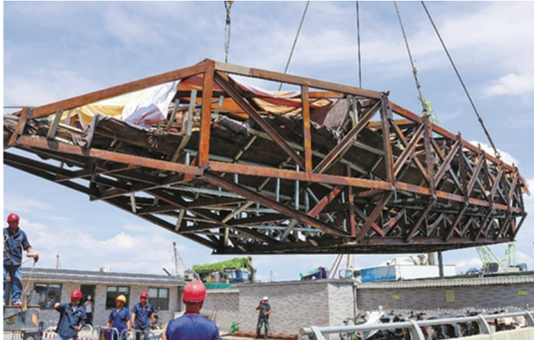
工作人员借助现场大型吊装设备,对2号沉船进行整体提取。 温州市文物考古研究所供图
